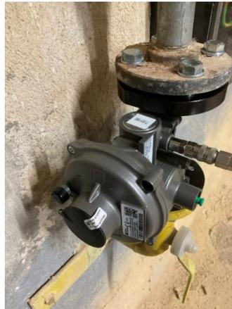
Der Erdgas-Hausanschluss: Hier liegt die Schnittstelle zur Gasübergabe „für den Hausgebrauch“ - und zugleich die Schnittstelle der Zuständigkeit. Denn: Ab der Haupt-Absperreinrichtung des Hausanschlusses liegt die Verantwortung für die Gasinstallation in den Händen von Eigentümern und Mietern.
